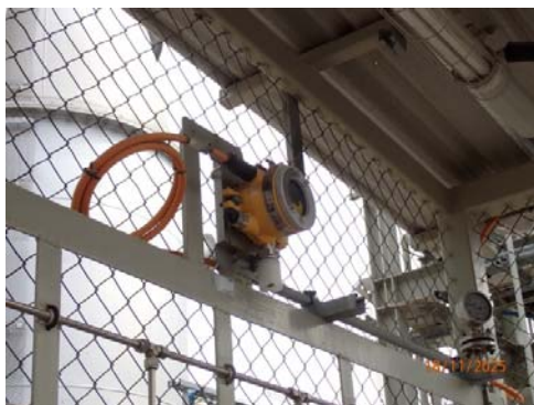
รูปที่ 5 Gas Detector ตรวจสอบการรั่วไหลของสารแอมโมเนียแอนไฮไดรต์
