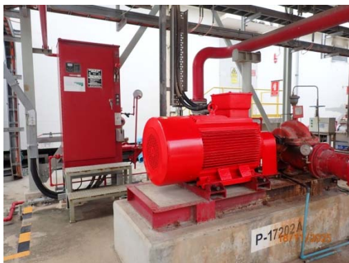
รูปที่ 64 เครื่องสูบน้ำดับเพลิง ประเภทขับเคลื่อนด้วยมอเตอร์ไฟฟ้า
