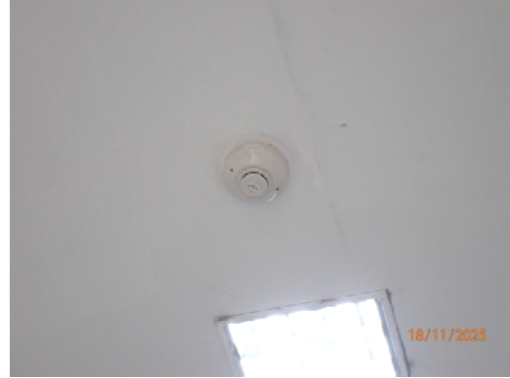
รูปที่ 69 อุปกรณ์ตรวจจับควัน (Smoke Detector)
