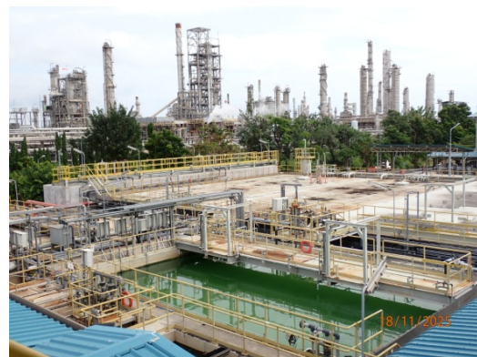
รูปที่ 17 ระบบบำบัดน้ำเสียแบบตะกอนเร่ง (Activated Sludge)
