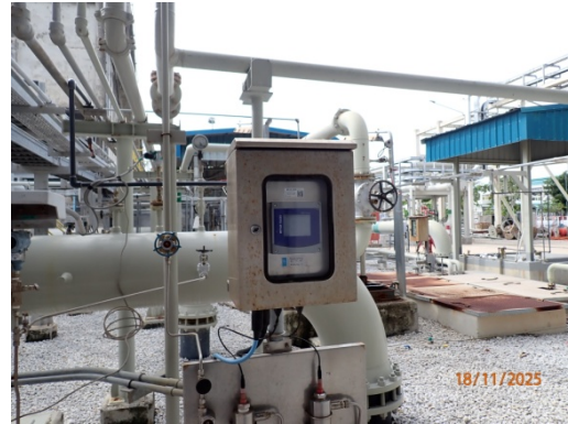
รูปที่ 19 pH Online และ Conductivity Online ของน้ำทิ้งจากหอหล่อเย็น
