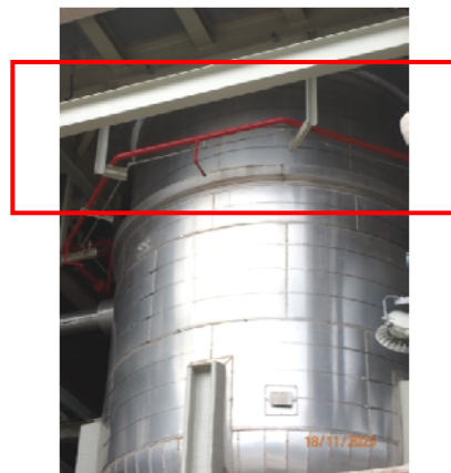
รูปที่ 47 ระบบการพ่นน้ำลงบนถังปฏิกิริยา (Reactor)
