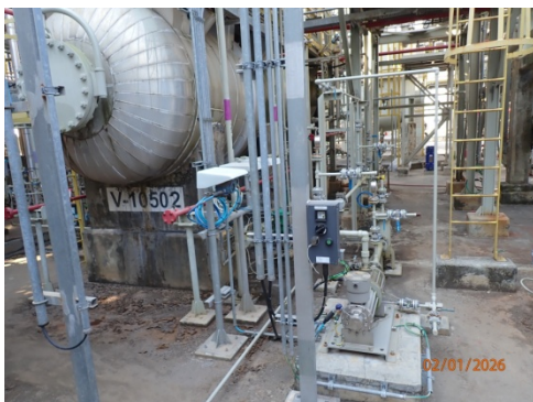
รูปที่ 6 ระบบนำอะคริไลไนไตรต์กลับมาใช้ใหม่
