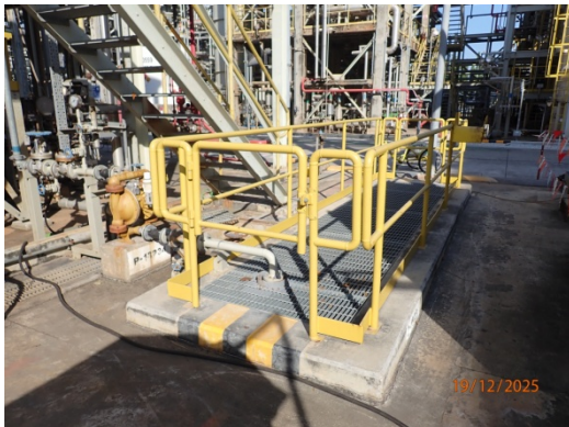
รูปที่ 14 Rain Sump Pit
