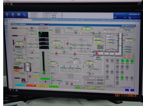
รูปที่ 2 ระบบ DCS ควบคุมการป้อนแอมโมเนีย
