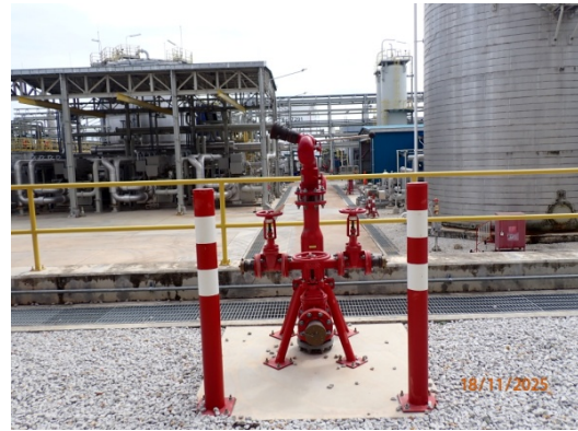
รูปที่ 51 หัวจ่ายน้ำดับเพลิง (Firewater Monitor)
