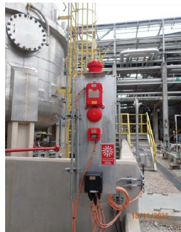
รูปที่ 71 สัญญาณเตือนเพลิงไหม้ (Fire Alarm Manual System)
