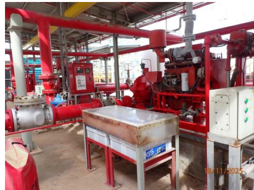
รูปที่ 65 เครื่องสูบน้ำดับเพลิง ประเภทขับเคลื่อนด้วยเครื่องยนต์ดีเซล
