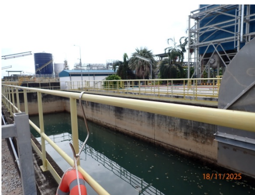
รูปที่ 16 บ่อพักฉุกเฉิน (Remote Impoundment Pond)
