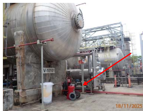
รูปที่ 55 ระบบป้องกันและระงับอัคคีภัยบริเวณถังเก็บกัก
