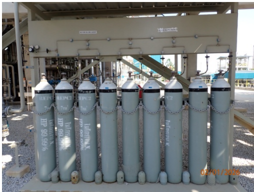
รูปที่ 56 ระบบก๊าซไนโตรเจน (Nitrogen Blanketing) บริเวณถังเก็บกัก
