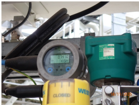
รูปที่ 3 Pressure regulator valve ของระบบป้อนแอมโมเนีย
