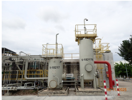
รูปที่ 10 ระบบหอดูดซับด้วยถ่านกัมมันต์ (AC Unit)
