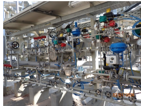
รูปที่ 4 ระบบควบคุมการขนถ่ายหรือลำเลียง ถังเก็บกักแอมโมเนีย
