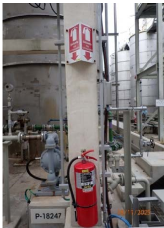
รูปที่ 52 ถังดับเพลิงแบบมือถือ (Portable Fire Extinguisher)
