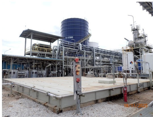
รูปที่ 11 บ่อพักน้ำเสีย (Surge Basin) (Z-18209A, Z-18209C และ Z-18209D)
