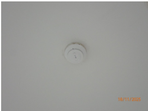
รูปที่ 70 อุปกรณ์ตรวจจับความร้อน (Heat Detector)
