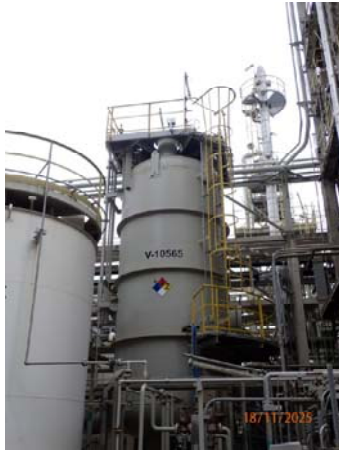
รูปที่ 12 ถังพักน้ำที่มีสารอะคริโลไนไตรล์ปนเปื้อน ประเภท Pressured Vessel (V-10565)
