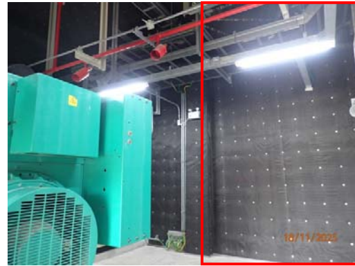
รูปที่ 35 ห้องควบคุมไฟฟ้าสำรองติดฉนวนดูดซับเสียง
